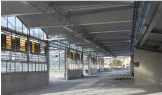
Slib ontvangst hal met bunkers
