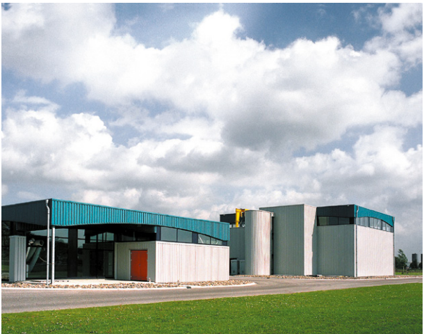
Kontinuierlicher Sandfilter für die Denitrifizierung mit 3.600 \text{ m}^3 / \text{h} Kapazität
