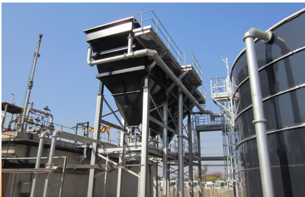
Lamellenschrägklärer-Einheit
