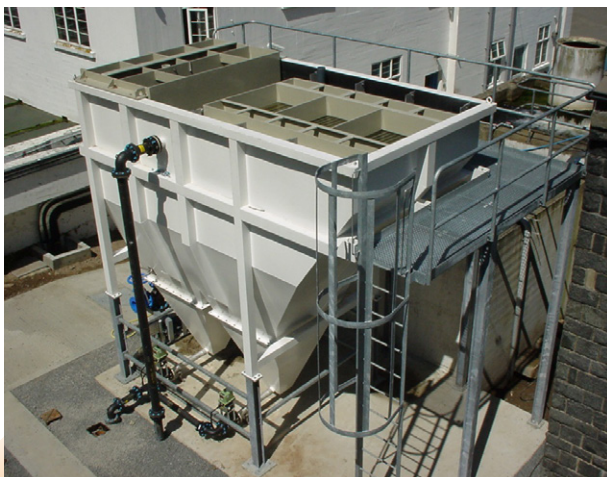
Kombinierte Koagulations-Flockungs-Lamellenabscheidung
